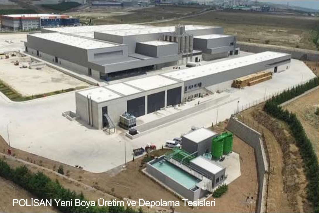
PULVER KİMYA Üretim ve Depolama Tesisleri
