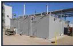
Patlamaya Dayanıklı Yapılar
